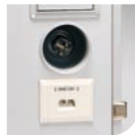
Netwerkaansluiting en elektriciteitsstekker
